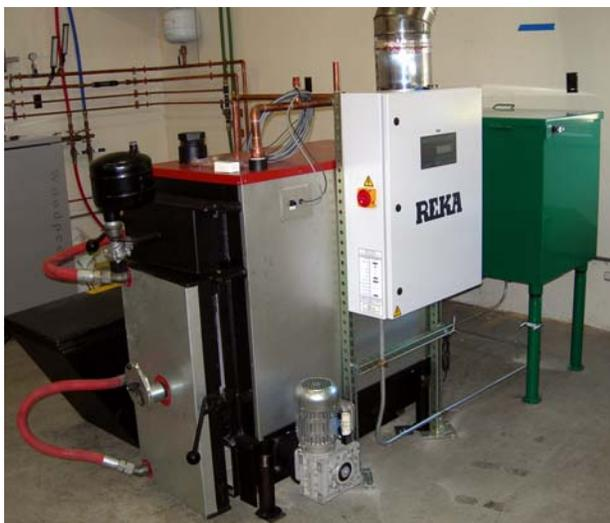
Fig. 1. Skanden (Reka) pellet boiler.
